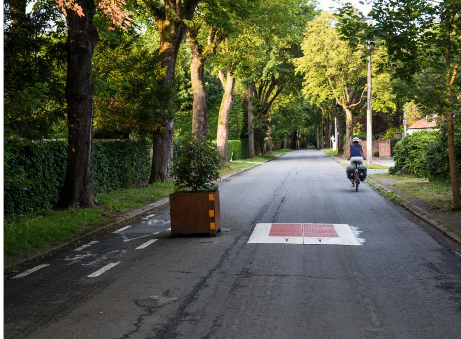
Obr. 38 ▲ Kvetináč je príkladom jednoduchšej, lacnej a estetickej šikany. Druhá strana vozovky je tu doplnená o dopravný vankúš – veľmi účinné v upokojovaní dopravy je práve kombinovanie viacerých druhov opatrení. Všimnite si priestor pre prejazd cyklistov ponechaný po oboch okrajoch ulice. 📍 Drève de la Meute, Waterloo, BE. Foto: Marek Zahradník
